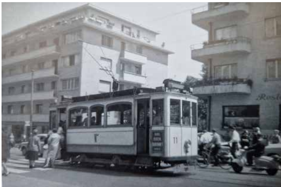
Wagen Ce 2/2 11 bei der Haltestelle Weggismatt stadteinwärts. Im Hintergrund Restaurant Viktoria
