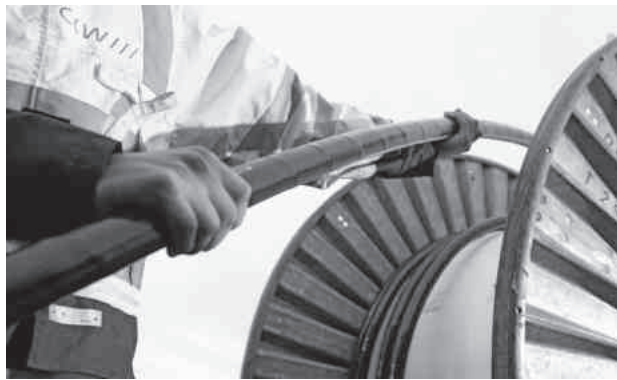
Abrollen des Stromkabels
