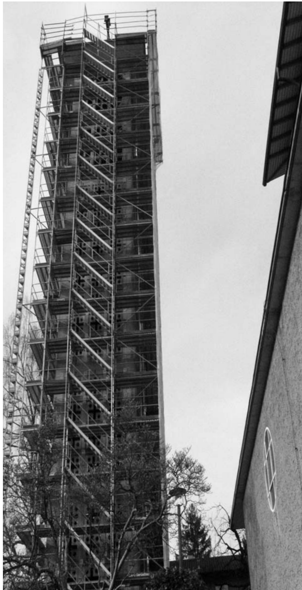
Turmgerüst am Maihofkirchturm
